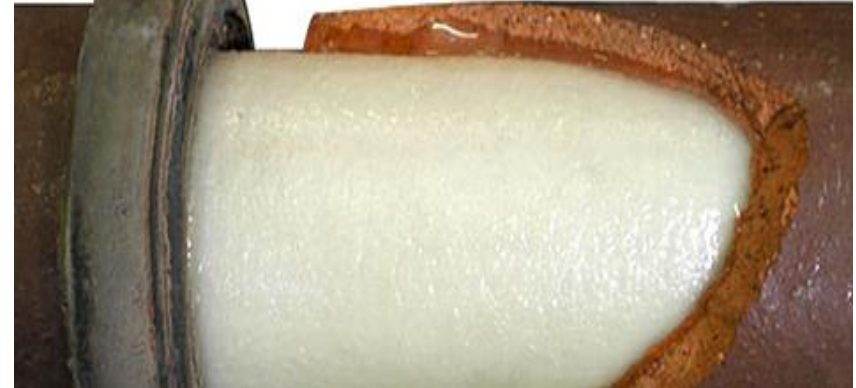
Ny innvendig strømppe i gammelt rør
